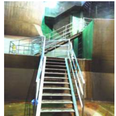
龍Q館地下階段の様子
